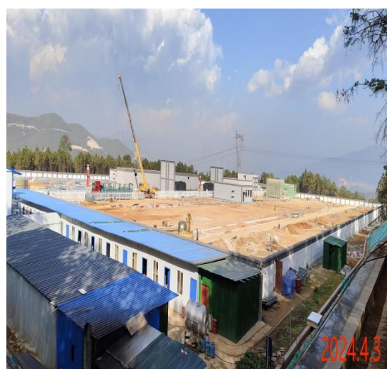
220kV 安丰营变
