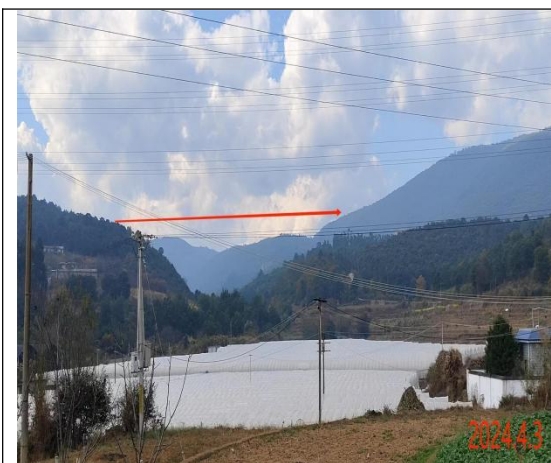
下穿 500kV 漫昆 I 回线
