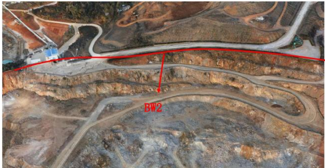
照片 3-2 BW 2 潜在不稳定边坡
