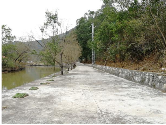
进场道路植被恢复情况
