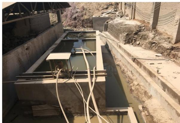
图片 8 水膜除尘器循环水池
