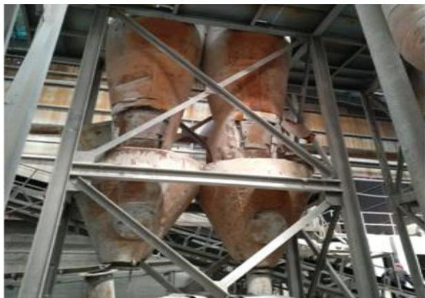
图片 5 项目烘干机旋风除尘器
